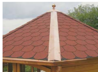
Dachgratabdeckung aus Kupfer
